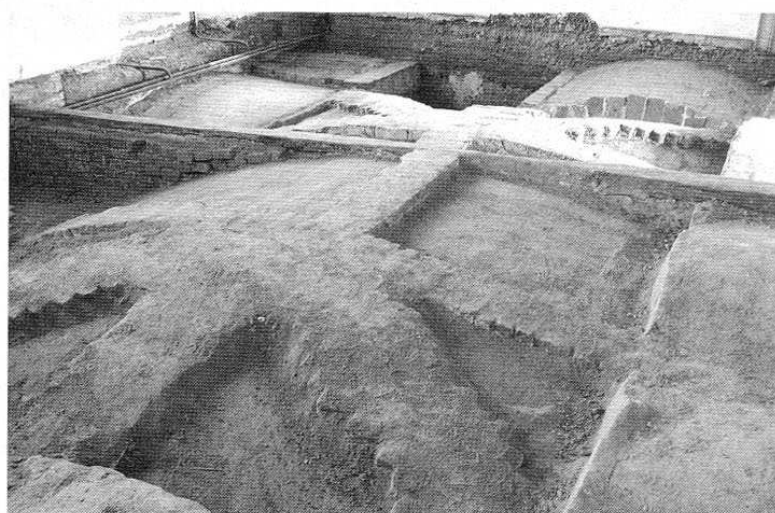
Fig. 7 Frugarolo (Al) Palazzo Migliazzi (già Polastri): veduta d'insieme del sistema voltato di un ambiente del piano nobile dopo la rimozione delle pavimentazioni (incongrue).
