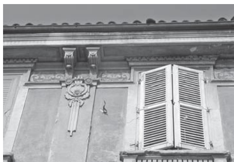
Fig. 6. Particolare del fregio dipinto posto sotto il cornicione.
