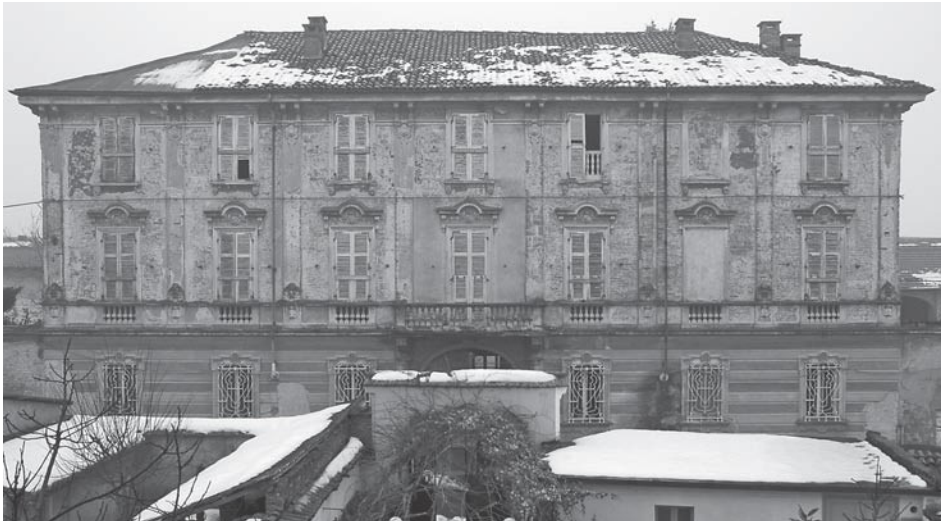
Fig. 1. Palazzo Migliazzi: Veduta d'insieme del prospetto principale su via Villanova.
